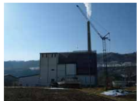
東部センター改修工事
